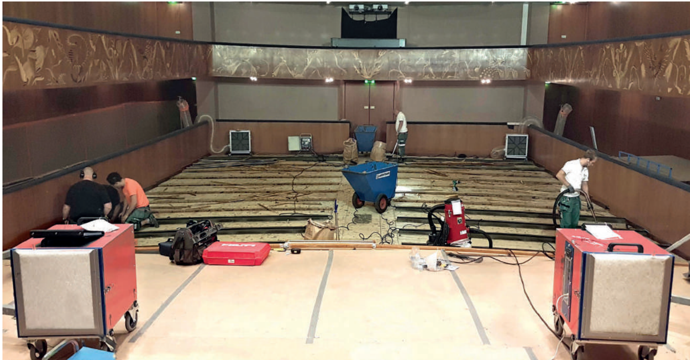
De två Jonex-aggregaten i förgrunden gör att dammet hålls på golvnivå. En del av dammet kan fångas upp av de två traditionella luftrenarna längst ner i salongen.
